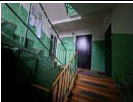
1.stāva kāpņu telpa
